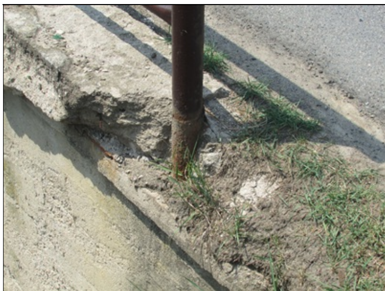
Degradace římsy - kotvení zábradlí
