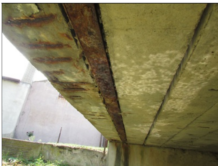
Podhled NK - korodující vložený ocelový profil
