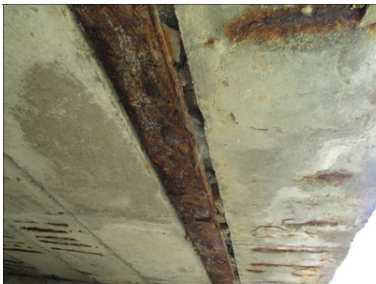
Podhled NK - korodující vložený ocelový profil
