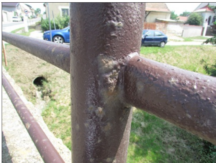
Detail koroze zábradlí
