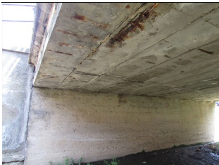
Podhled NK - obnažená a korodující výztuž
