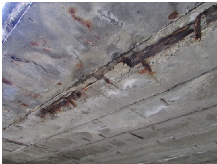
Podhled NK - obnažená a korodující výztuž
