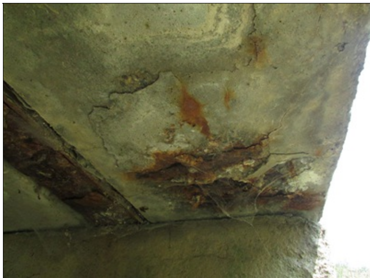
Podhled NK - obnažená a korodující výztuž
